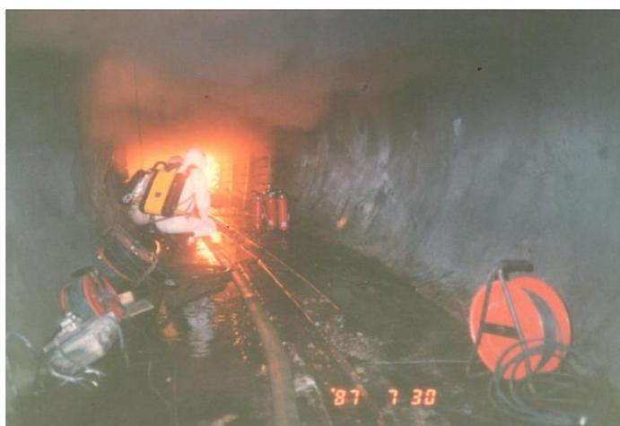
第 23 図 通気速度の遅い場合の坑道火災燃焼ガスと煙の逆流（通気速度  $0.5 \text{ m/s}$ ）
