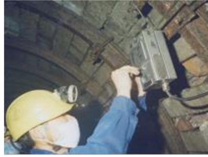
第 34 図 Mao Khe 炭鉱に設置された集中監視システム（右は坑内の CH<sub>4</sub> センサー）
