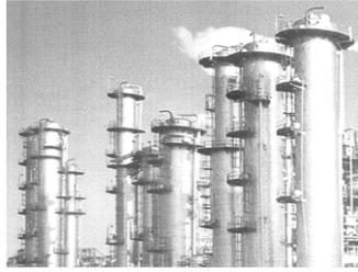
石油精製・化学工業のコンビナートのタワー群はほとんどが蒸留塔。原油換算33.2百万kℓ/年を消費するエネルギー多消費産業であり、そのうちの約40%が蒸留プロセスで消費。
