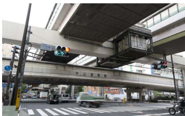
図 23 三層構造の東京都板橋区大和町交差点（国道 17 号線の北側を望む。首都高速道路上下線の橋脚中央に換気施設が見える）
