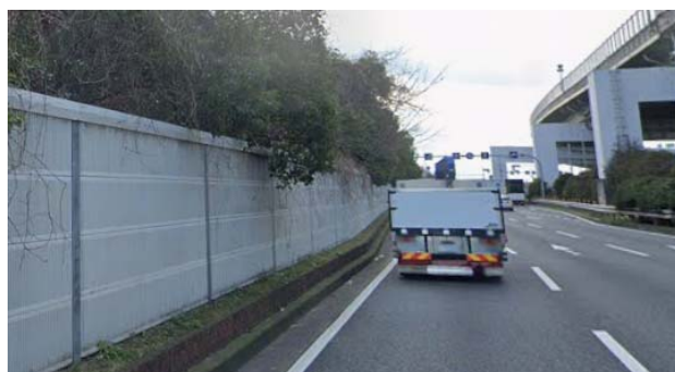
図 25 泉大津市の新型遮音壁（長さ 500 m）
