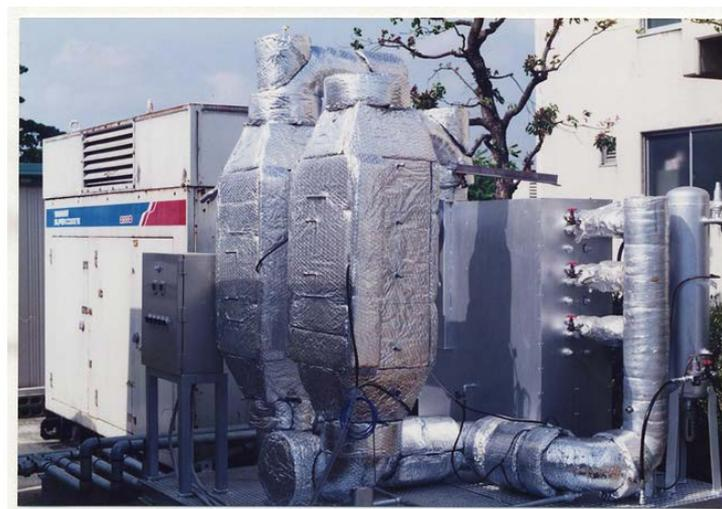
図25 定置式ディーゼルエンジン排ガス脱硝触媒システムの外観
